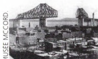
MUSEE MACCORD 1929. La construction du futur Pont Jacques-Cartier qui nécessitera 33 000 tonnes d'acier.
