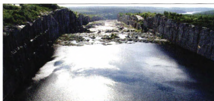
L'évacuateur des crues du barrage LG2.
