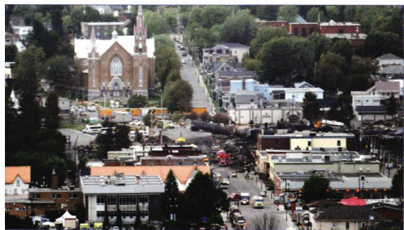
Le désastre rue Frontenac, à deux pas de l'église Sainte-Agnès.
