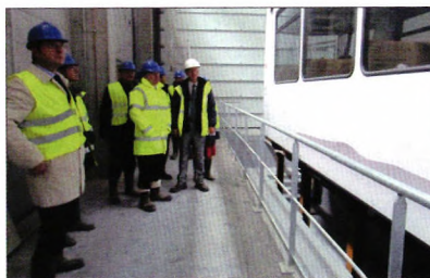
Le président du Cercle des dirigeants d'entreprises franco-québécois et le Délégué général du Québec sur le chantier SNC-Lavalin.
